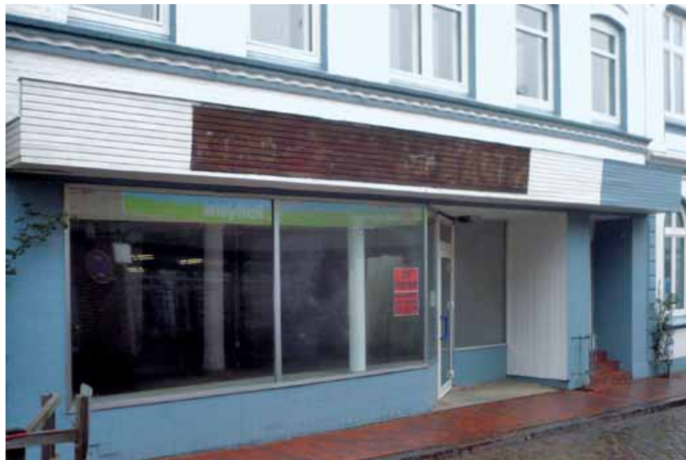
Viele Geschäfte stehen leer, wie hier in Garding.
